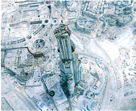
Un chantier inachevé
